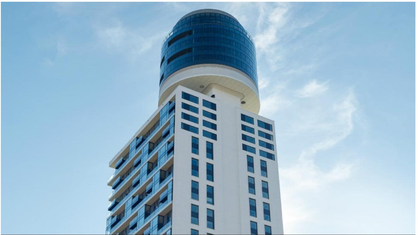
Neues Wahrzeichen mit Pixelfassade | Henninger Turm von Saint-Gobain
