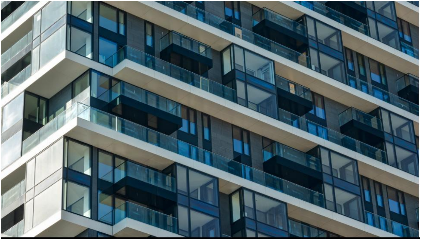
Neues Wahrzeichen mit Pixelfassade | Henninger Turm in Frankfurt
