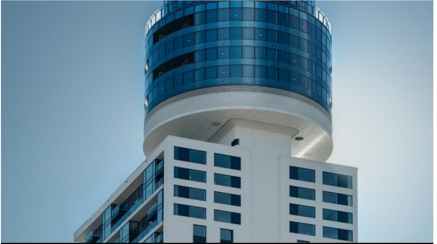
Neues Wahrzeichen mit Pixelfassade | Henninger Turm in Frankfurt
